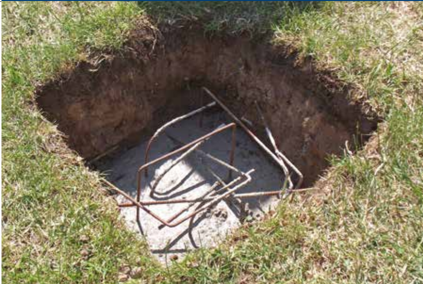
Das Fundament für die Säule mit Armierung
