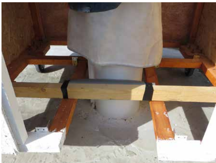
Einfache Wegfahrsicherung durch einen Kantholzbalken
