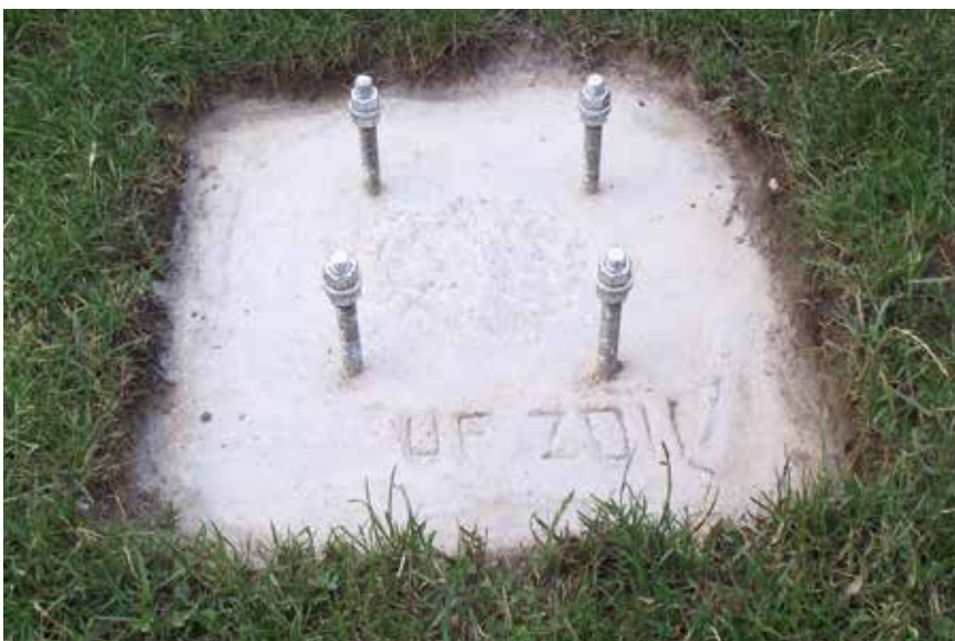
Das fertige Fundament für die Säule
