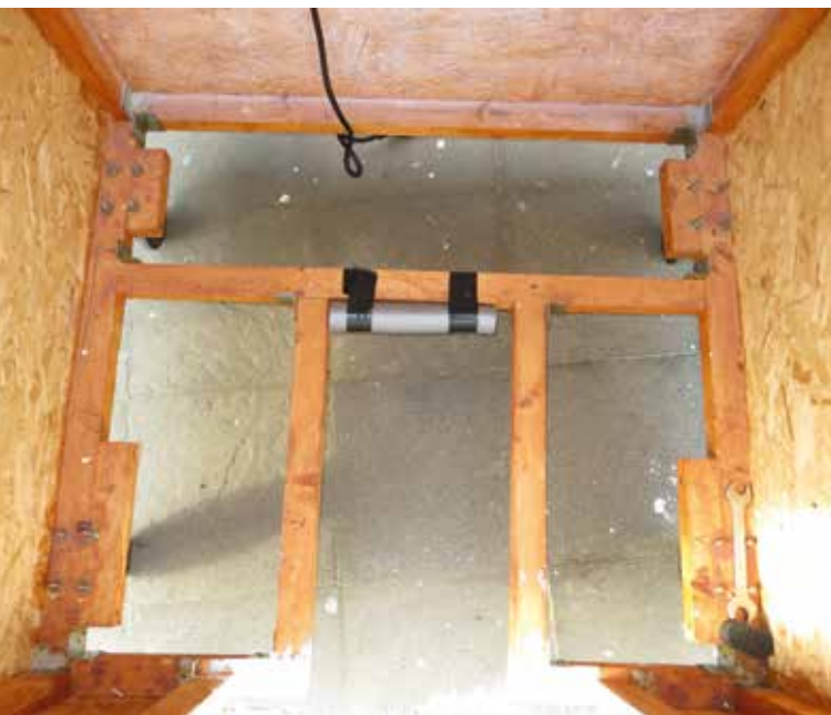
Das Bodenskelett mit den montierten Rollen
