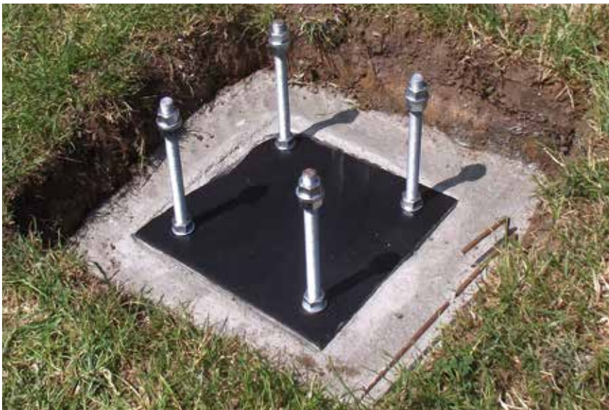
Das Fundament für die Säule mit Stahlplatte
