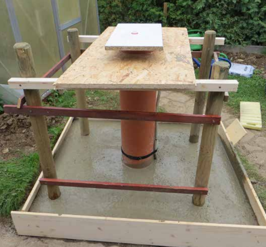
Rohrjustierung mit OSB-Platte und Wasserwaage
