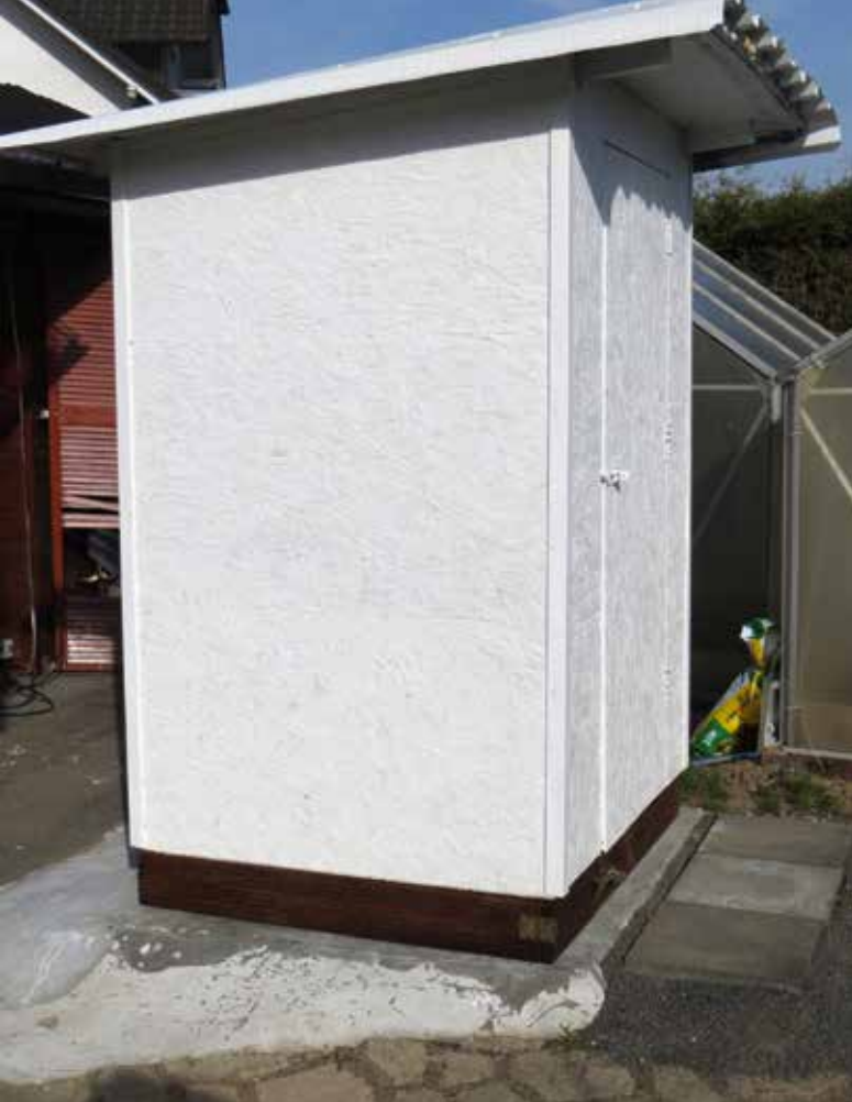
Die fertige Rollschutzhütte mit umlaufendem Bodenrahmen
