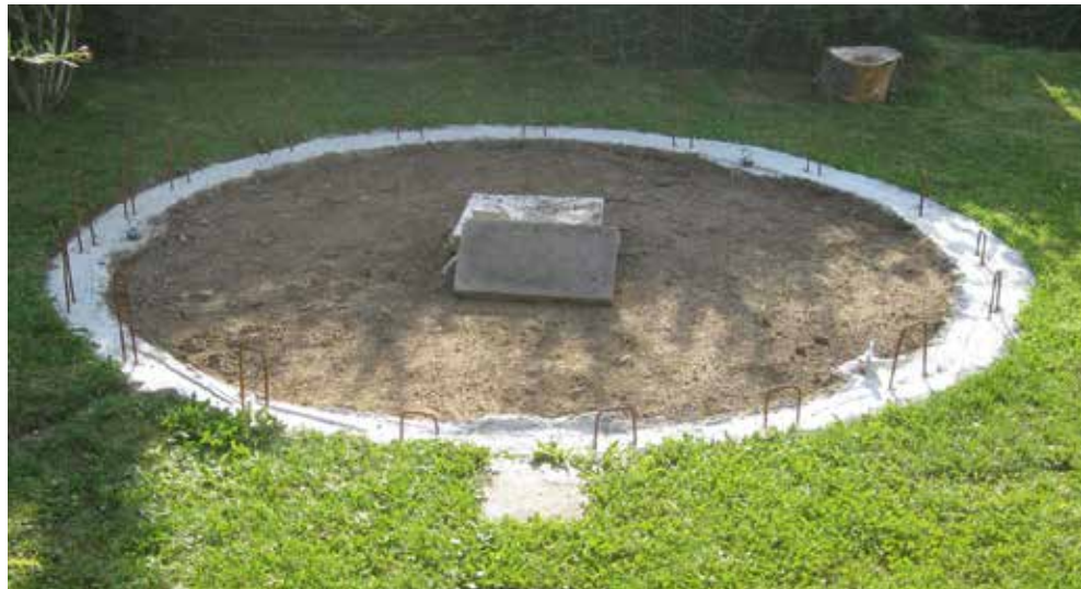
Das runde Betonfundament mit einem Durchmesser von 320 Zentimetern
