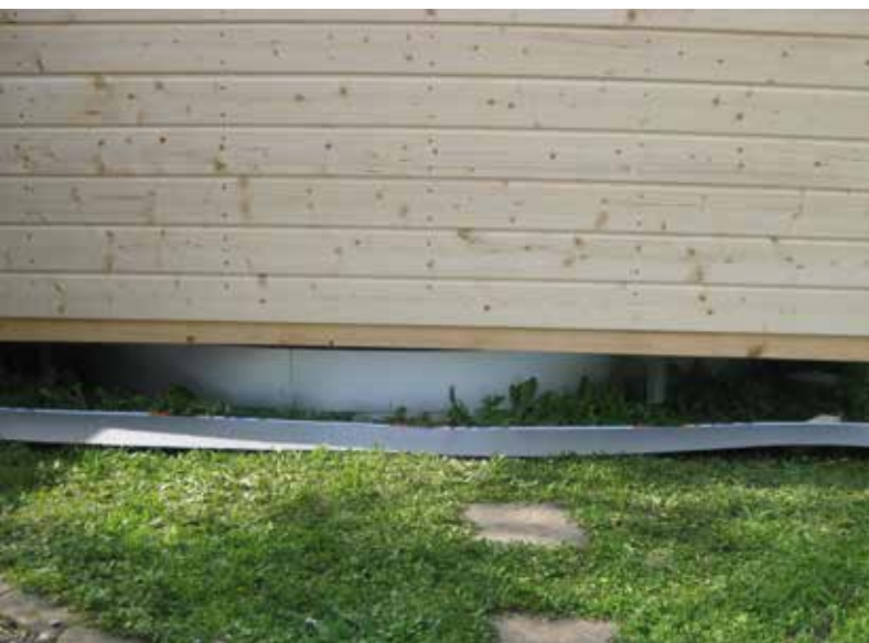
Der Betonring ist an der Außenseite mit einem 28 cm breiten Aluminiumblech verkleidet.
