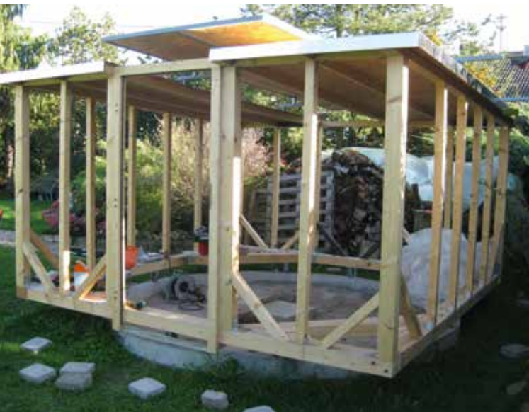
Das Gerüst mit der Abdeckung und dem Dachspalt
