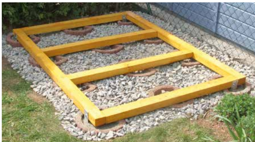
Das Fundament mit der Unterkonstruktion
