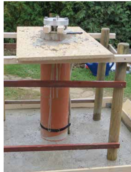
Die Betonsäule mit Adapter nach dem Guss
