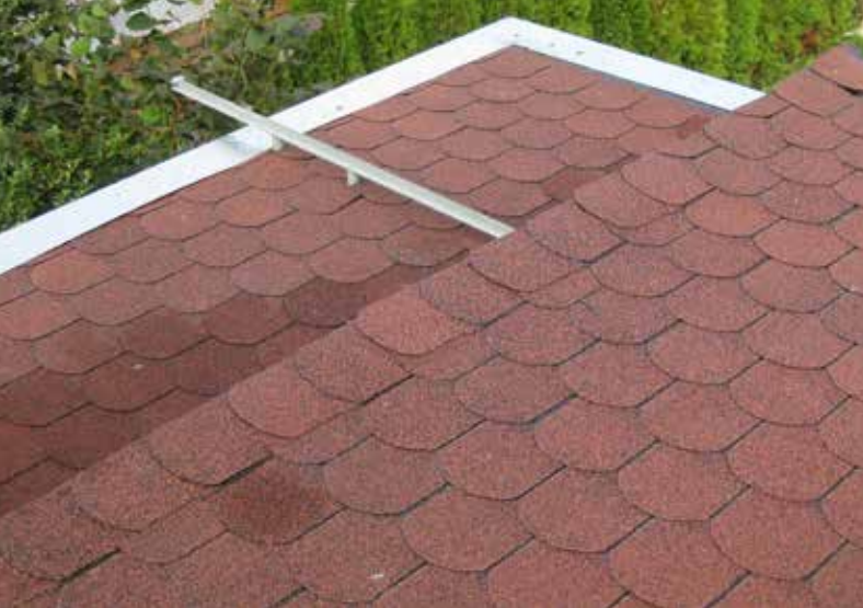
Dachabdeckung mit Biberschindeln
