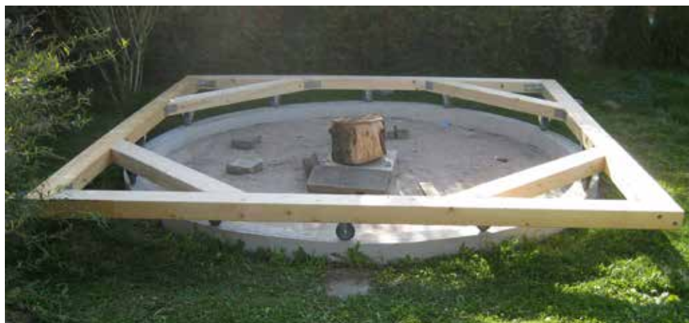
Der untere Rahmen mit den zwölf Nylonrollen
