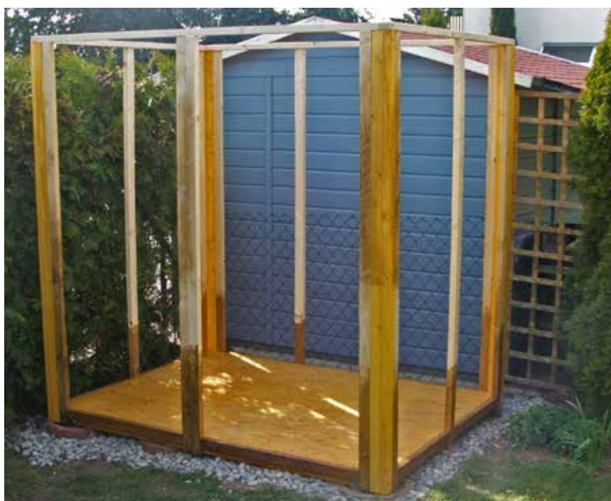
Der Fußboden und das Konstruktionsgerüst
