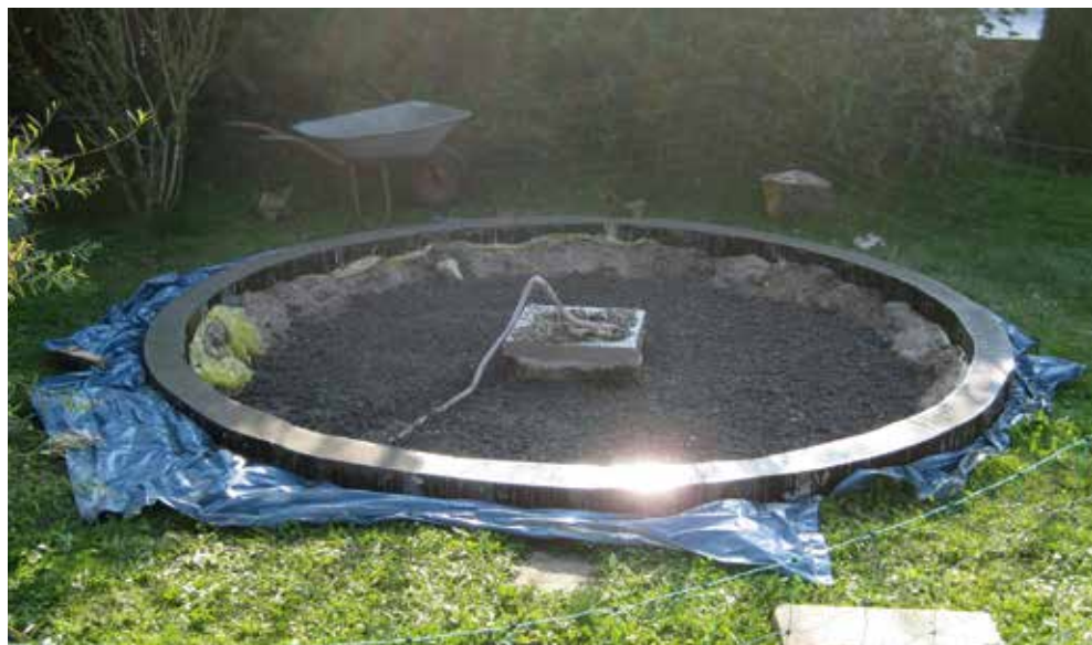
Die Schalung musste exakt ins Wasser gebracht werden.
