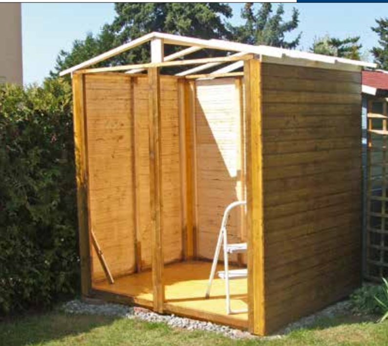
Die Seitenwände und die Dachkonstruktion
